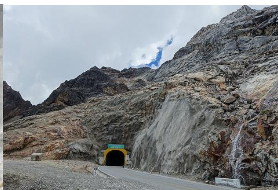
Punta Olimpica Tunnel
